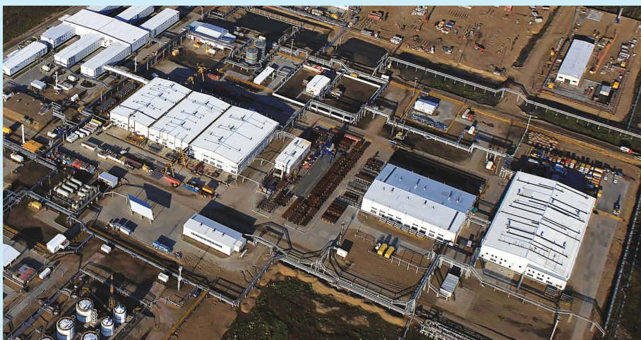
Системы температурной стабилизации «ГЕТ» и «ВЕТ» в основании производственных зданий Ванкорского месторождения. Использование данных систем позволяет строить здания блокированного типа.
