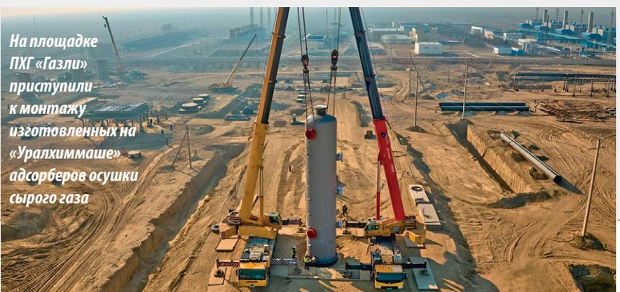
На площадке ПХГ «Газли» приступили к монтажу изготовленных на «Уралхиммаше» адсорберов осушки сырого газа
