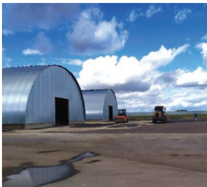
На территории ОПХ «Орловское» уже построено 5 складов со стеллажами для хранения
